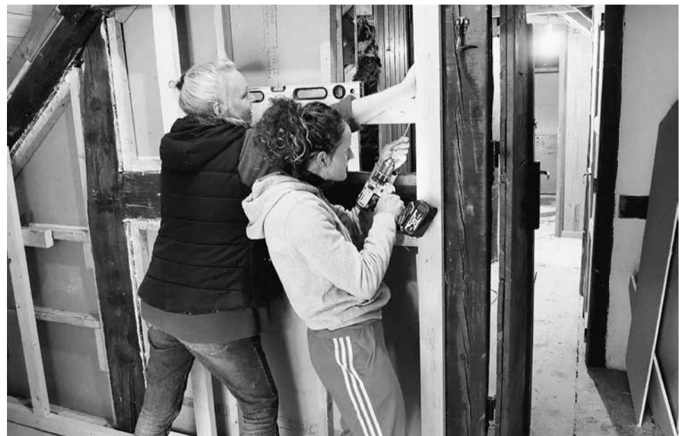
Behalve onder het dak werd ook binnenshuis de isolatie vernieuwd. Anne en Valentine waren hier onvermoeibaar mee bezig.
