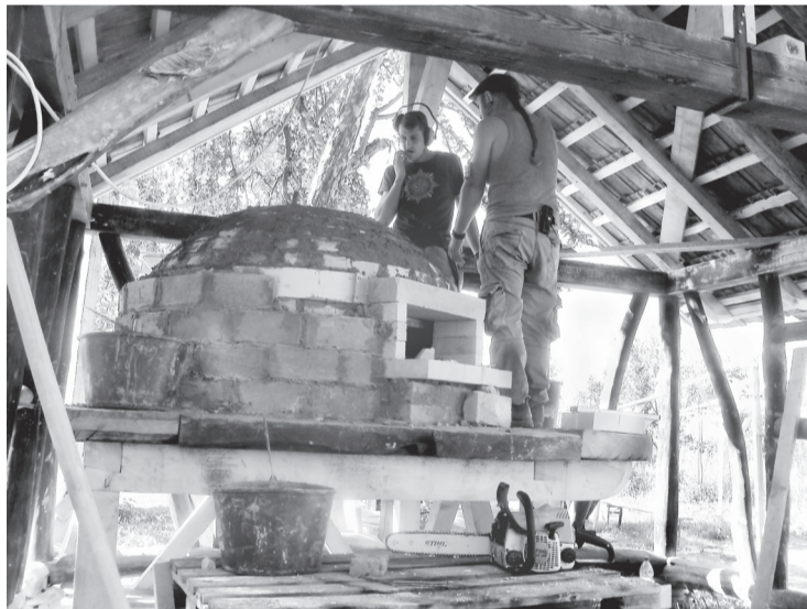
Bouw van de broodbakoven en bakhuis.
