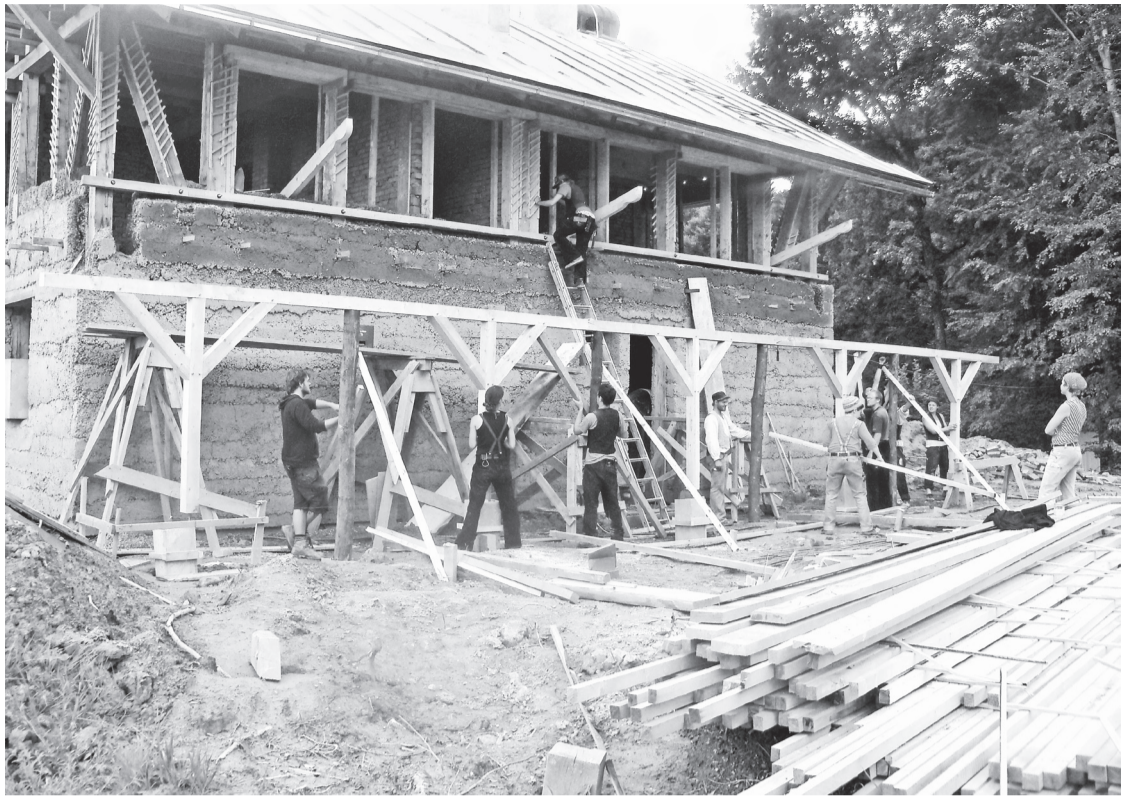
Vele handen maken licht werk: Bouw van een afdak aan het nieuwe gemeenschapshuis op Zeleny Haj. Dit nieuwe huis is een welkome aanvulling op de reeds beschikbare woonruimte.
