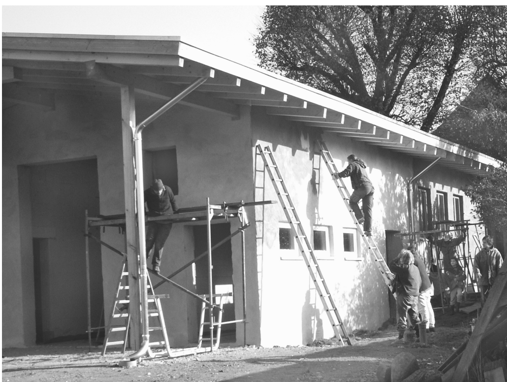
Na drie jaar bouwen is het grootste gedeelte van het alternatieve energieproject op Hof Ulenkrug in Mecklenburg af. Het centrale verwarmingshuis werd in september met kalkpigment steenrood geverfd.
