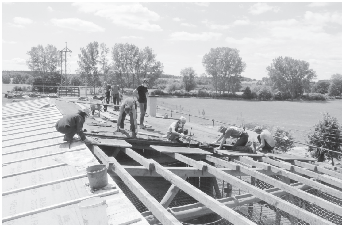
In juni scheen de zon in Mecklenburg. Op Hof Ulenkrug werden de oude asbestplaten van het dak van de schuur gehaald, de verrotte balken vervangen en nieuwe golfplaten gelegd.
